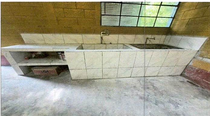
Foto 3: pila y mueble para cocina terminados.
