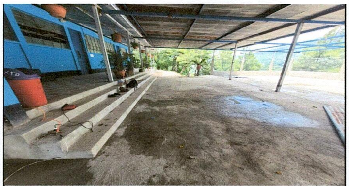
Foto 6: banqueta, gradas y torta de cemento reparadas.
