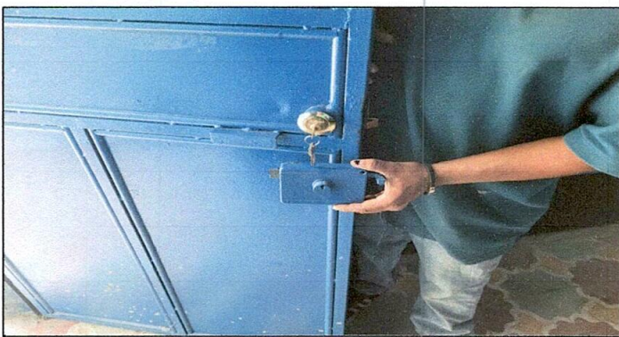
Foto 5: cambio de chapa y mantenimiento de puerta.
