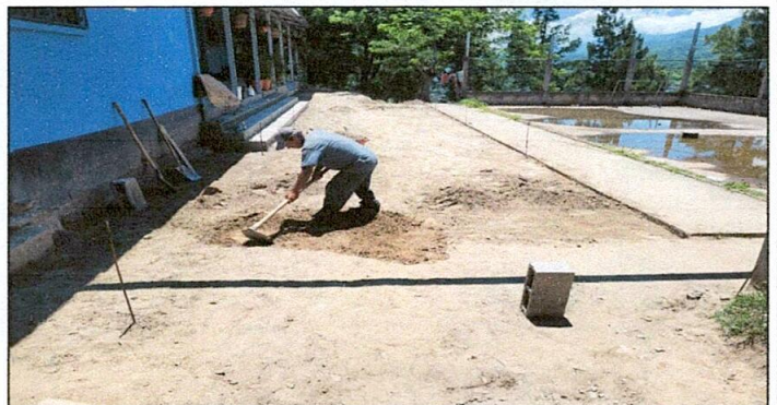
Foto 6: reparación de banqueta y torta de concreto.
