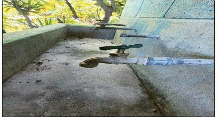
Foto 2: reparación de chorros.
