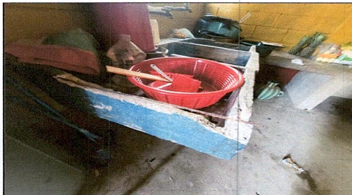
Foto 3: pila quebrada y con fuga.
