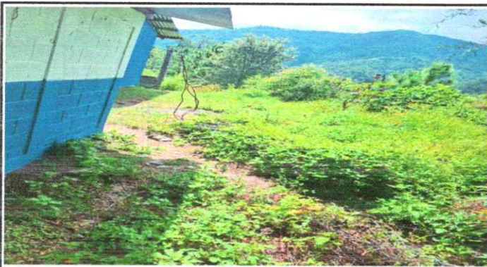
Foto 3: Mejoramiento del Muro Perimetral
