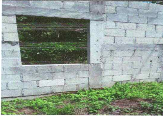
Foto 1: Pared de cocina sin concluir
