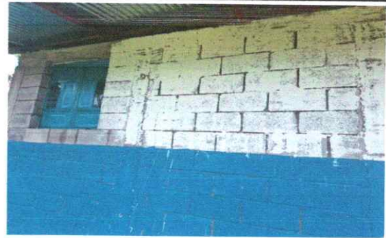
Foto 2: Pintura Deteriorada
