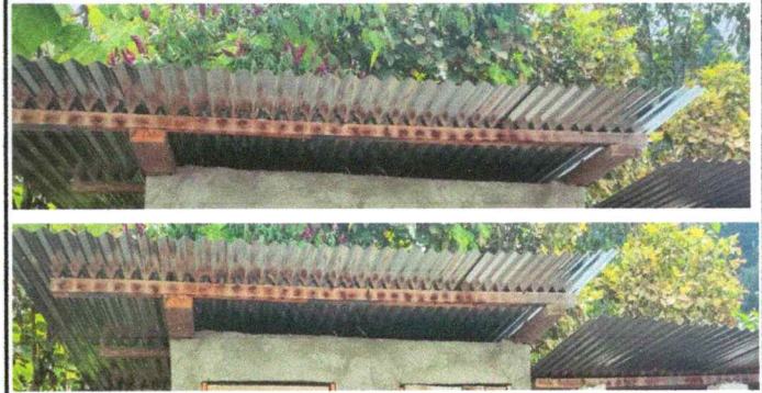
Foto 2: Sustitución de sostenimiento por costaneras.
