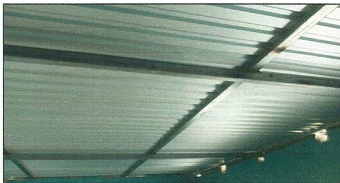
Foto 5: Sustitución de estructura de soporte
