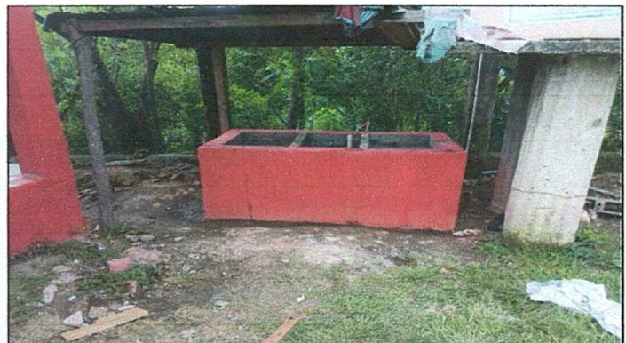
Foto 4: Sustitución de pila
