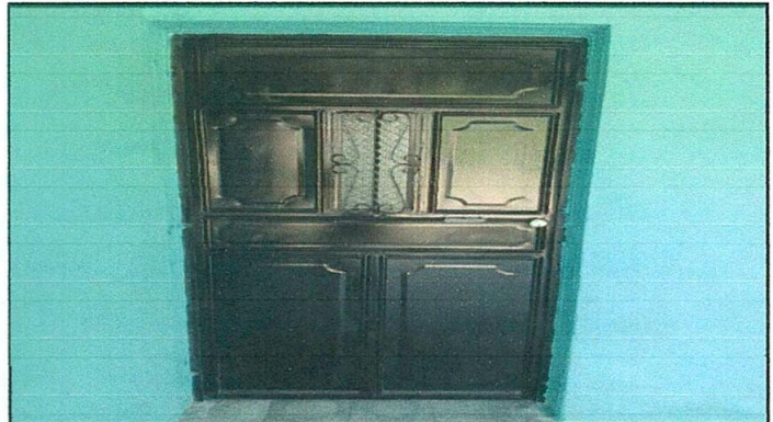
Foto 2: Sustitución de puertas de madera por puertas de metal
