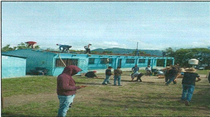
Foto 1: Sustitución de lámina por lámina troquelada
