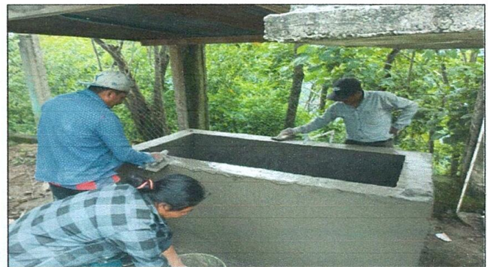
Foto 4: Sustitución de pila
