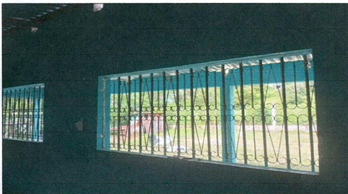
Foto 3: Sustitución de ventanas
