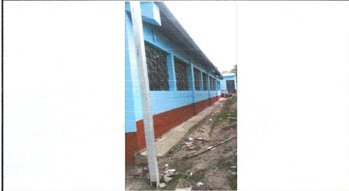
Foto1: Lámina y estructura de soporte terminada
