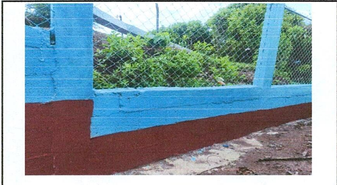
Foto 4: Nueva circulación terminada
