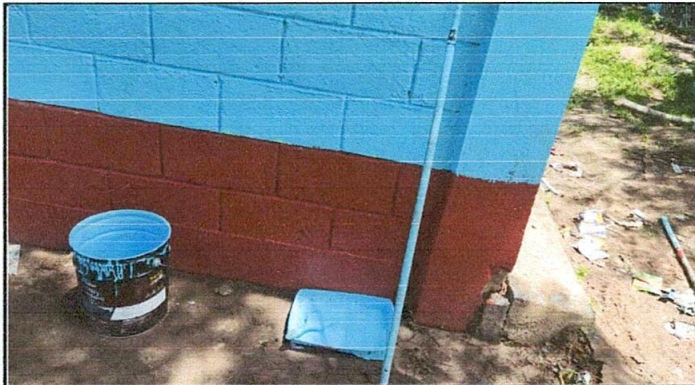
Foto 3: Pintando paredes de exteriores
