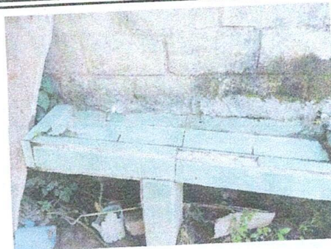
Foto 2: Sustitución de lavamanos
