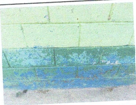
Foto 3: Sustitución de pintura
