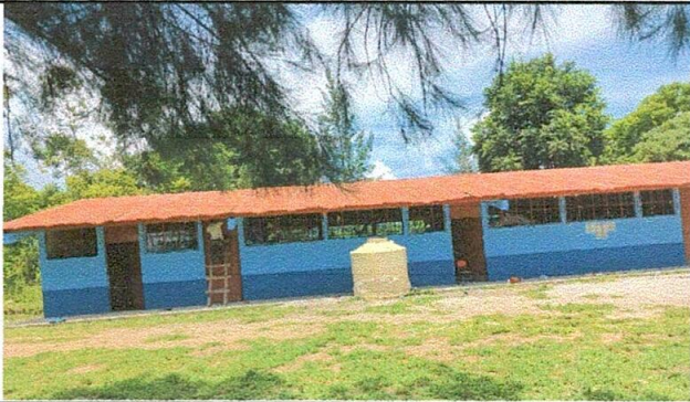
Foto 5: PINTURA EN MUROS EXTERIORES E INTERIORES
