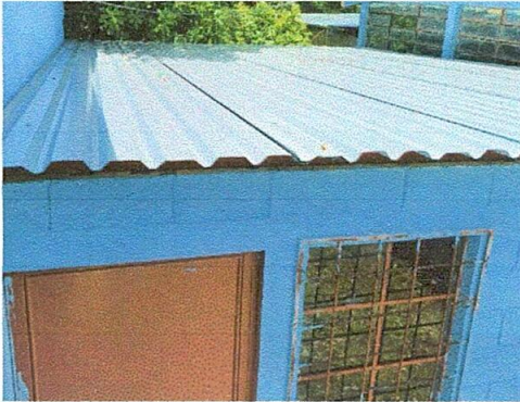
Foto1: CUBIERTA DE LÁMINA
