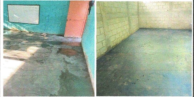
Foto 4: SUSTITUCIÓN DE PISO EN COCINA Y AULAS
