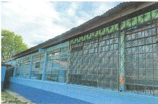
Foto 3: SUSTITUCIÓN DE VIDRIOS
