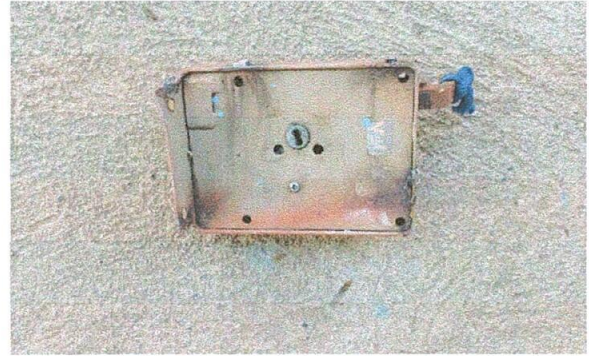
Foto 2: SUSTITUCIÓN DE CHAPA
