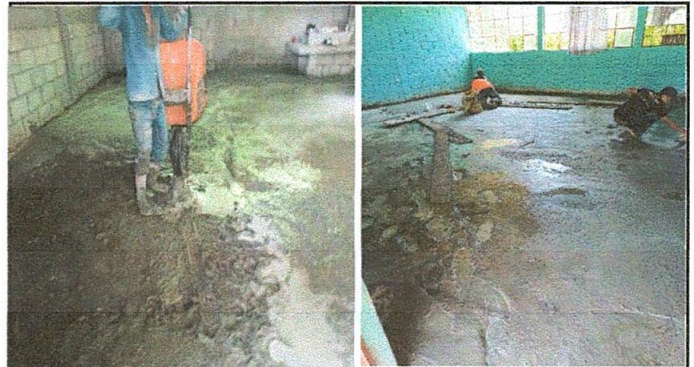
Foto 4: SUSTITUCIÓN DE PISO EN COCINA Y AULAS
