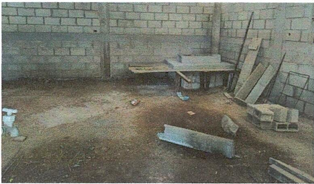
Foto 9: SUSTITUCIÓN DE PLANCHA, CHIMENEA Y PILA DE CEMENTO
