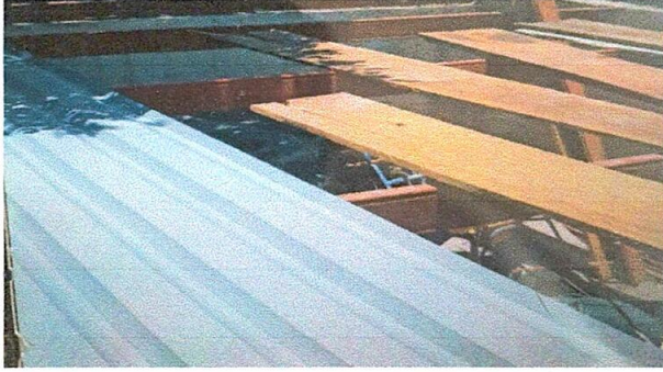
Foto1: CUBIERTA DE LÁMINA
