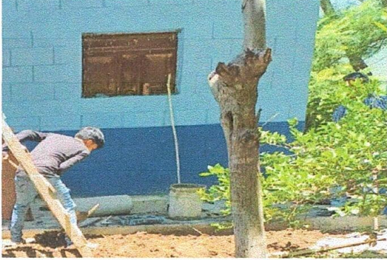
Foto7: SUSTITUCIÓN DE RED DE DRENAJE Y AGUA POTABLE
