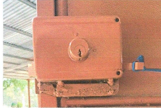
FOTO 2: SUSTITUCIÓN DE CHAPAS
