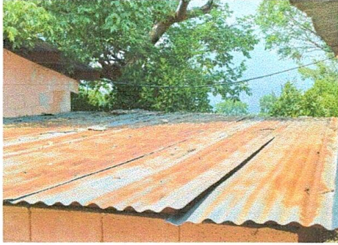
FOTO 1: CUBIERTA DE LÁMINA
