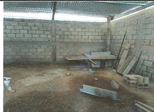
FOTO 4: SUSTITUCIÓN DE CEMENTO LÍQUIDO COCINA Y AULAS
