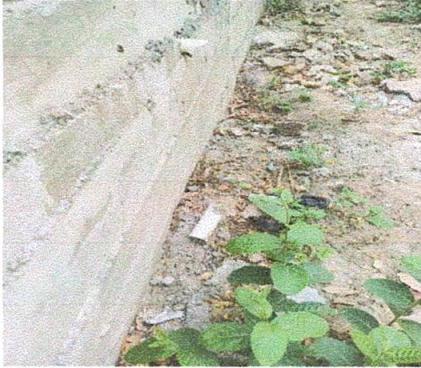
FOTO 7: SUSTITUCIÓN DE RED DE DRENAJE Y AGUA POTABLE
