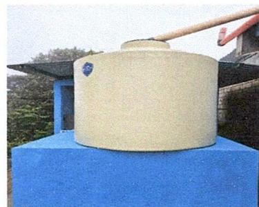
Foto 6: Base de cemento para deposito de agua de 2500 lts
