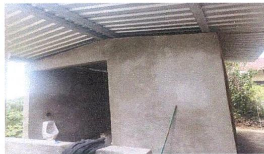
Foto 6: Base para colocar el tinaco
