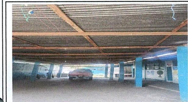
Foto 1: lámina y estructura de soporte en malas condiciones
