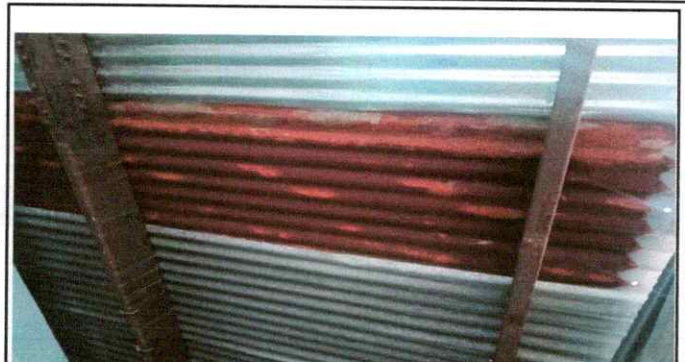
Foto 2: Estructura de techo
