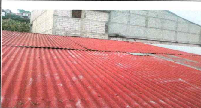
Foto1: Cubierta de láminas
