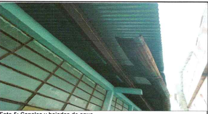
Foto 5: Canales y bajadas de agua
