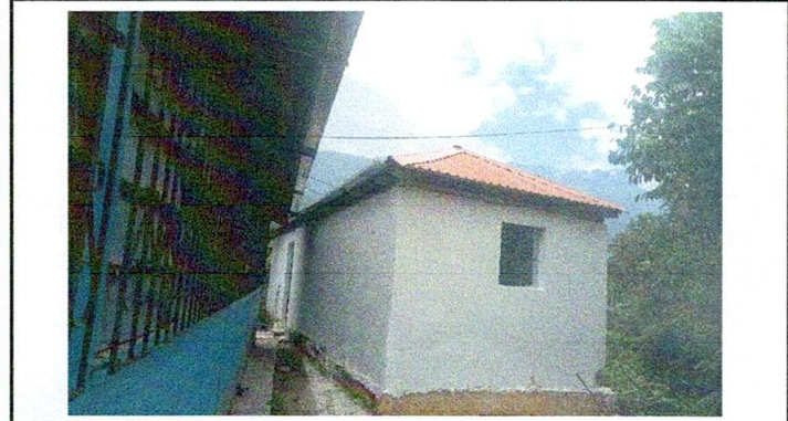
Foto 1: Cambio de lamina
