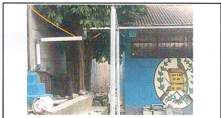
Foto 5: Cambio de canales bajada de agua
