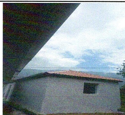
Foto 10: Reparación de repello
