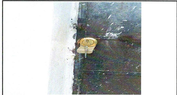
Foto 3: Cambio de accesorios de chapa
