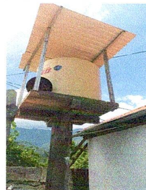
Foto 8: Sustitución de depósito de agua
