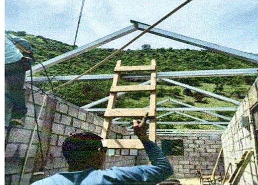
Foto 2: estructura metalica para cambio de techo
