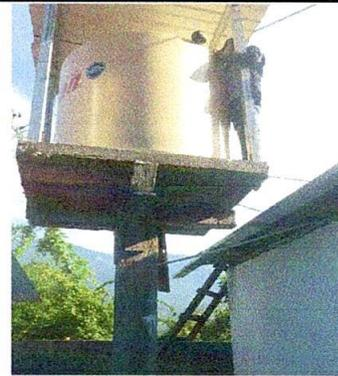
Foto 8: Sustitución de depósito de agua
