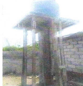
foto 8: sustición de deposito de agua
