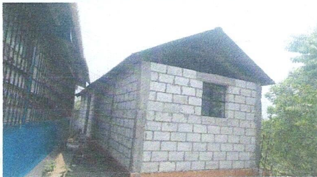
Foto: Mejoramiento de Techo. (cambio de lamina)
