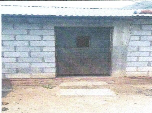
foto 3: cambio de chapa
