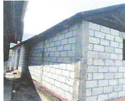
foto 10: reparación de repello
