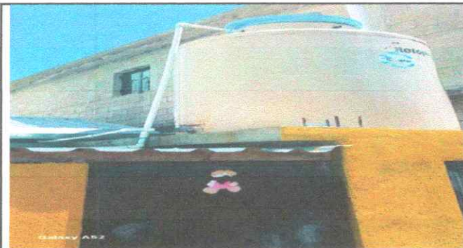
Foto 11: Deposito de Agua
