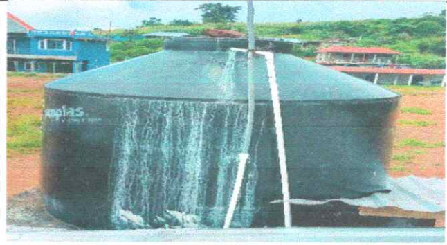
Foto 10: Deposito de Agua
