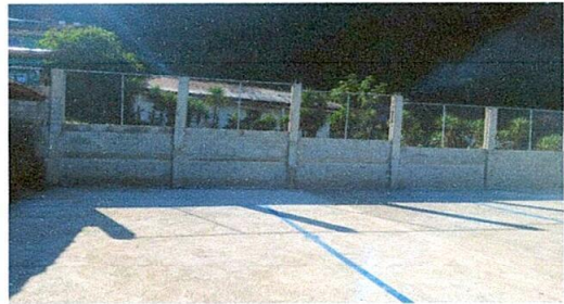
Foto 4: muro perimetral concluido
