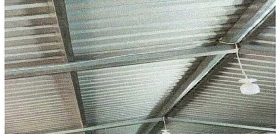
Foto 2: sustitución de madera por metal finalizada.
