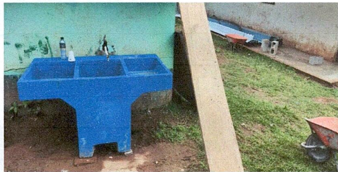
Foto 3: sustitución de pila
