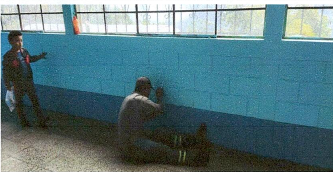
Foto 5: reparación de corriente eléctrica en proceso
