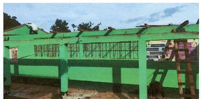
Foto 6: cambio de lámina en proceso
