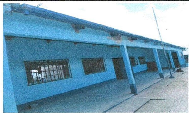
Foto 6: sustitución de canales de metal por metal.
