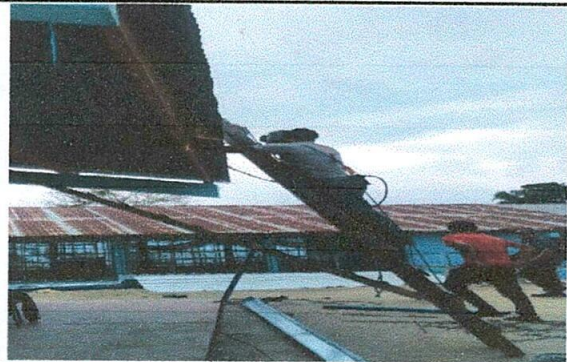
Foto 6: sustitución de canales de metal por metal.
