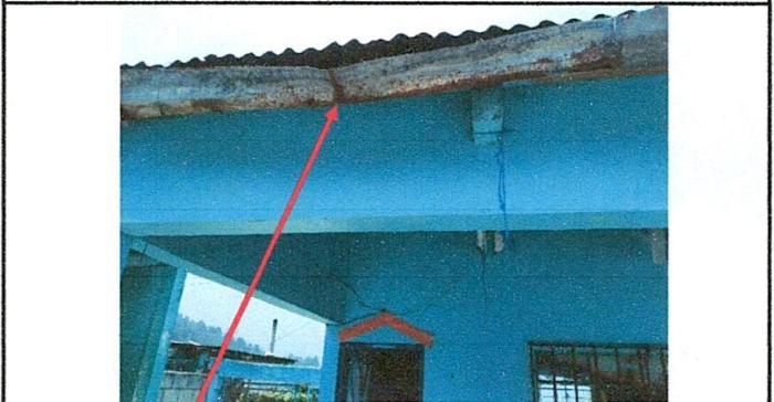
Foto No. 6. Sustitucion de canales de metal por metal.
