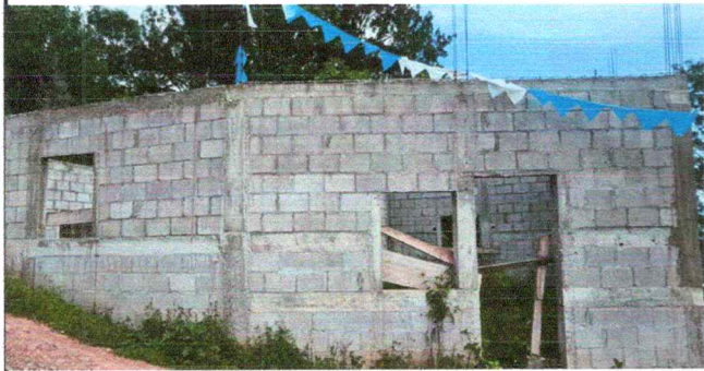
Foto 1: Pared de cocina
