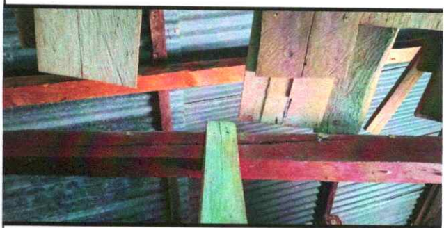
Foto 4: Madera agrietada
