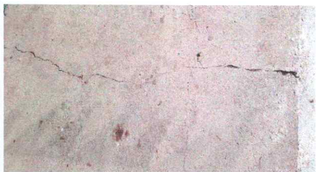
Foto 8: Piso agrietado
