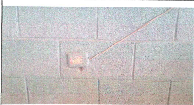
Foto 7: Deterioro de tomacorrientes
