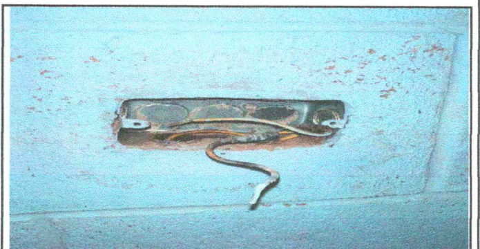
Foto 6: Inexistencia y deterioro de interruptores
