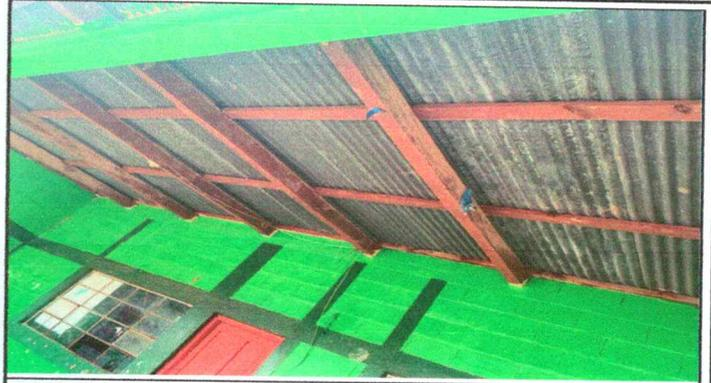
Foto 2: Estructura de soporte de madera
