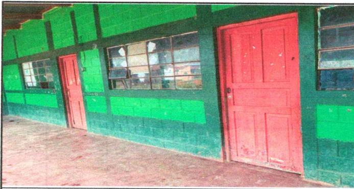
Foto 5: Puertas de madera ya deterioradas
