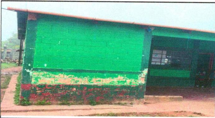
Foto 3: Estado de la pintura en las paredes del aula
