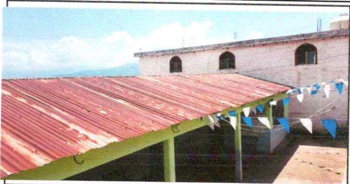
Foto 2: Lamina deteriorada
