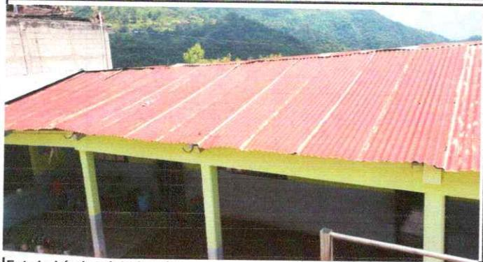
Foto1: Lámina deteriorada.
