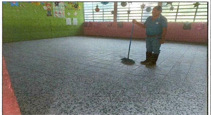
Foto 4: SUSTITUCIÓN DE PISO, SEGUNDO GRADO.
