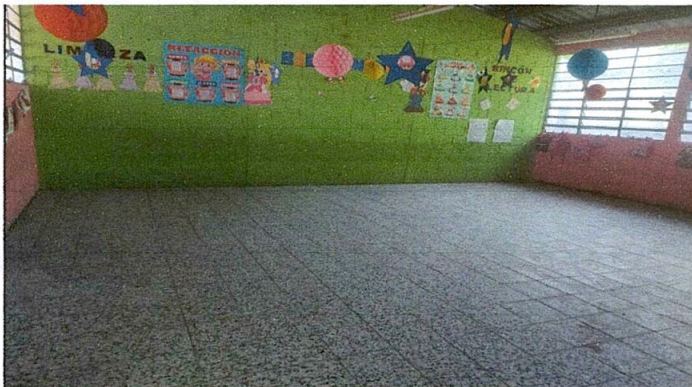
Foto 3: SUSTITUCIÓN DE PISO, PRIMER GRADO.
