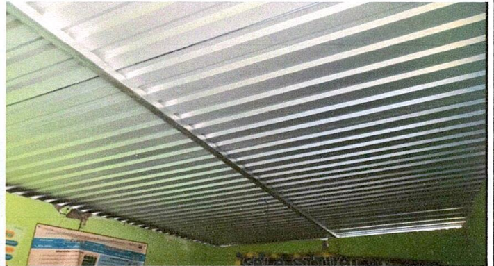
Foto 2: BODEGA: INSTALACIÓN DE ESTRUCTURA DE METAL.
