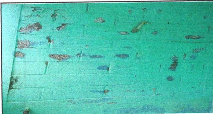
Foto 5: pintura deteriorada
