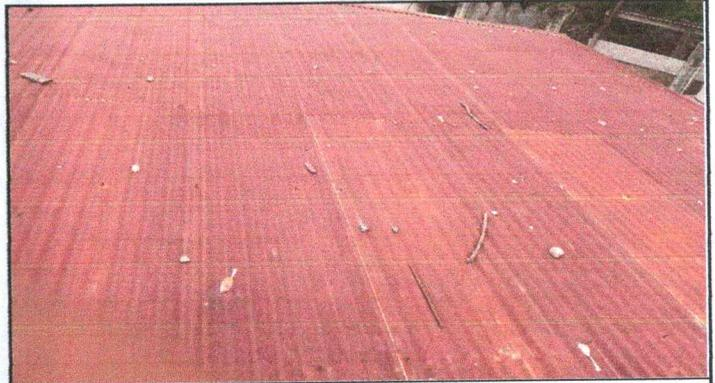
Foto 2: Techo, lamina deteriorada
