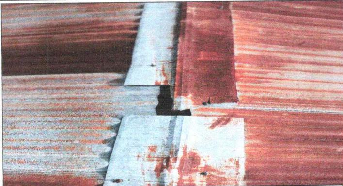
Foto 1: Techo predio No. 2, lámina deteriorada.
