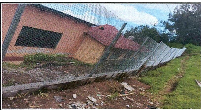
Foto 5: Muro perimetral con tubo hg y malla galvanizada
