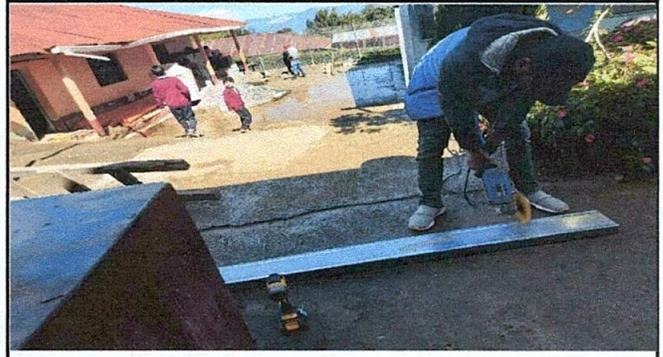
Foto 2: Sustrucción de canales y bajadas de agua pluvial de pvc por metal
