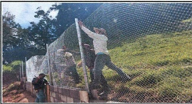
Foto 5: Reparación de muro perimetral con tubo hg y malla galvanizada
