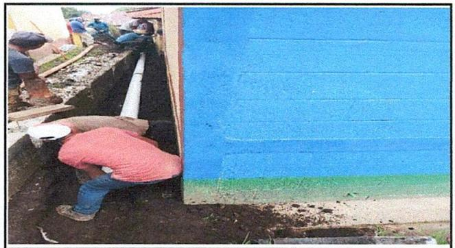
Foto 4: Sustrucción de tubería PVC línea principal aguas negras y sustitución de cajas de registro
