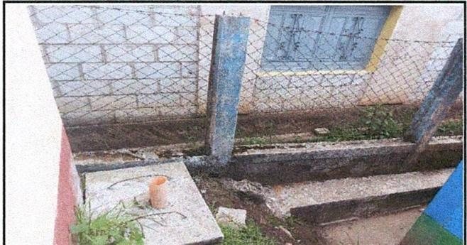
Foto 4: Sustitución de tubería PVC línea principal aguas negras y sustitución de cajas de registro
