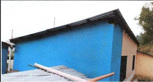
Foto1: Estructura de soporte y elementos de fijación en malas condiciones
