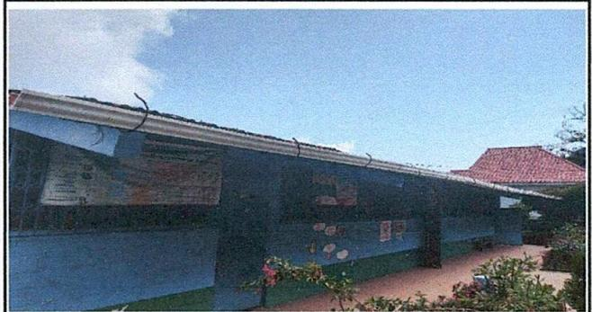
Foto 2: Canales y bajadas de agua pluvial en malas condiciones
