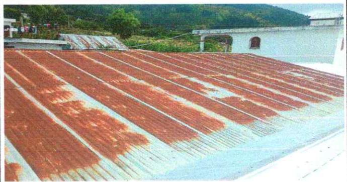
Foto 2: Lamina a cambiar
