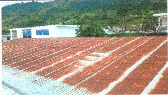
Foto1: Lámina deteriorada
