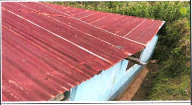
Foto 2: Cubierta de lámina
