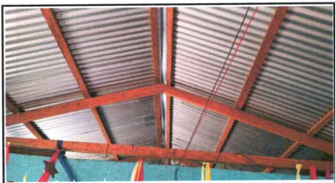
Foto 3: Estructura de techo
