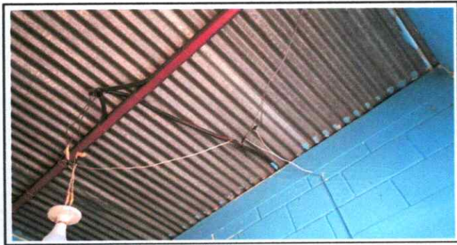
Foto 6: Reparación de sistema eléctrico
