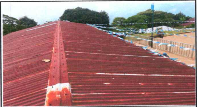
Foto 1: Cubierta de lámina
