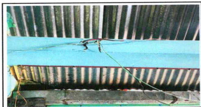
Foto 5: Reparación de sistema eléctrico
