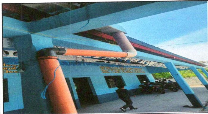
Foto 9: Canales en mal estado
