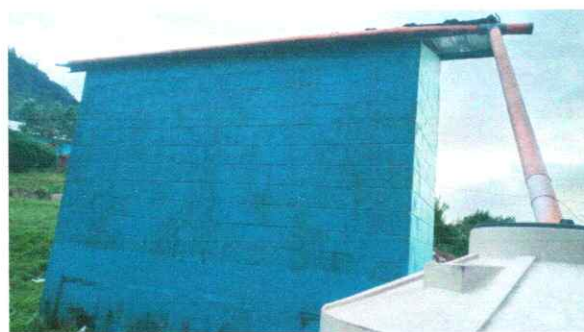
Foto 4: Paredes y canal
