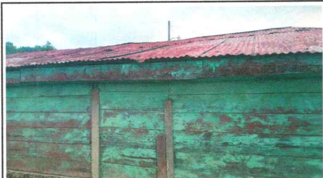
Foto 1: Lámina y estructura de soporte
