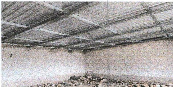
Foto 5: estado del repello en malas condiciones
