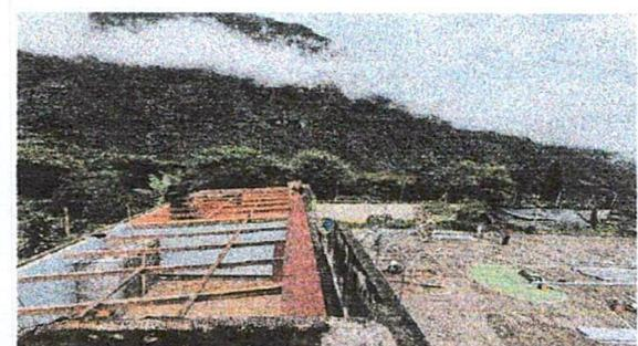
Foto 4: madera de soporte en malas condiciones
