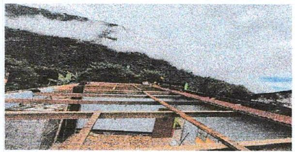
Foto 2: láminas en malas condiciones
