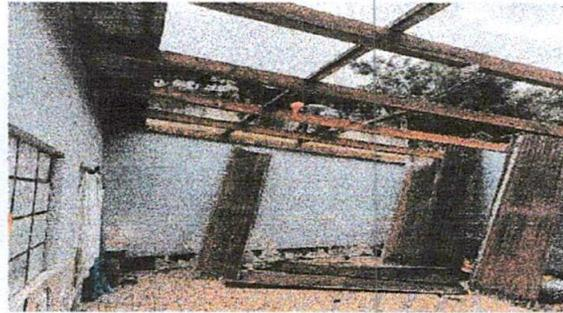
Foto 3: sustitución de estructura de soporte
