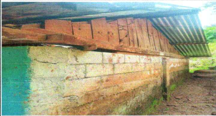
Foto1: Techo de cocina
