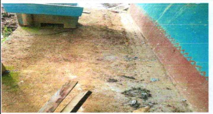
Foto 3: Piso de cocina
