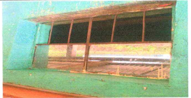
Foto 8: Ventanas de cocina
