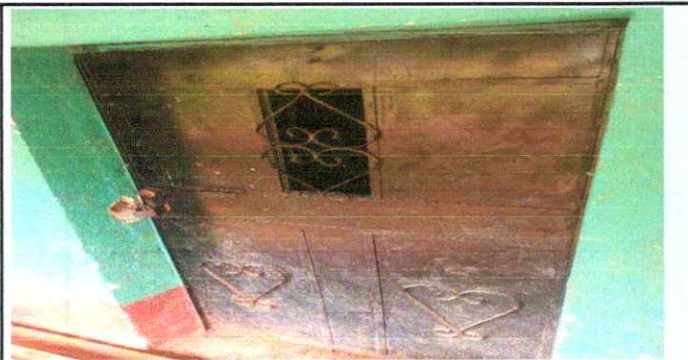
Foto 5: Puerta de cocina
