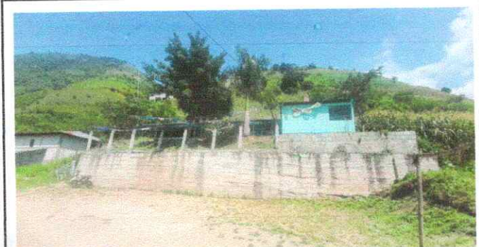
Foto 6: Circulación en muro perimetral en mal estado y riesgoso para los niños.
