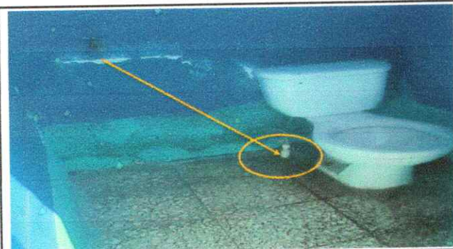
Foto 5: mala conexión de red de agua a los servicios sanitarios.
