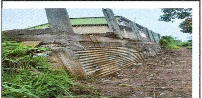
Foto 6 muro de contención finalizado
