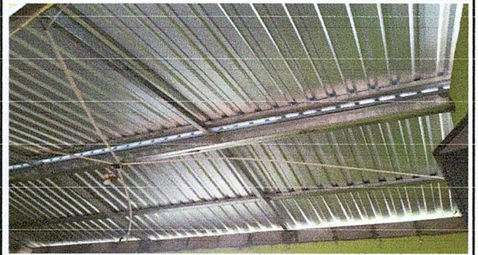
Foto 2. Madera sustituida por metal
