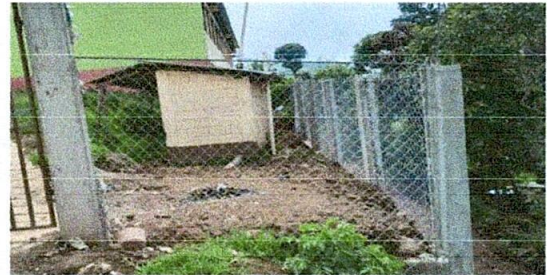
Foto 4. Muro perimetral reparado
