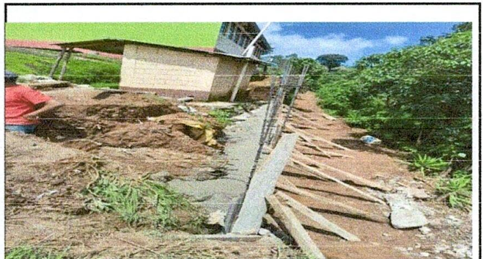
Foto 4. reparación del muro en proceso.
