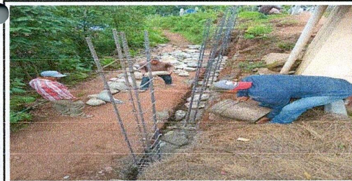
Foto 5. Fundiendo cimiento del muro con piedra, cemento y hierro.
