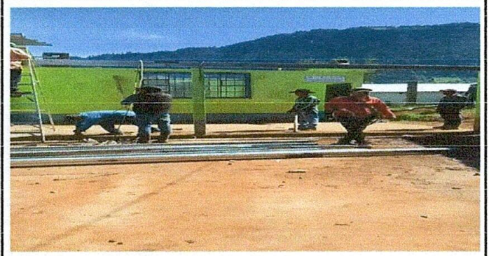
Foto 2 Soldando costaneras e instalando los tubulares.
