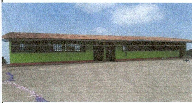
Foto 3. sustitucion de canaletas de metal
