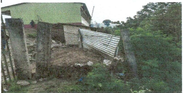
Foto 4. reparaçión de muro perimetral
