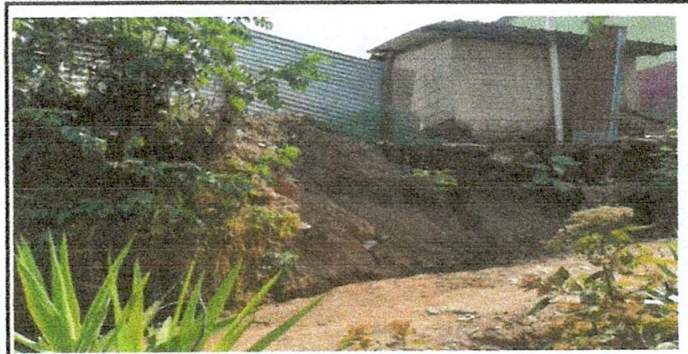
Foto 6. Reparación de muro perimetral
