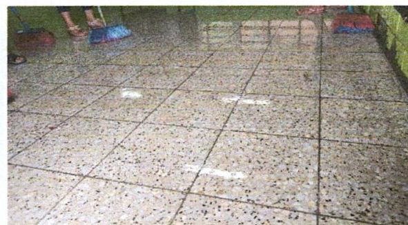
Foto4: sustitucion de piso
