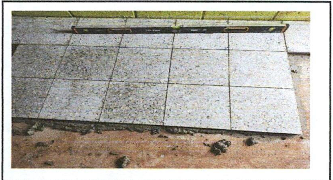
Foto4: sustitucion de piso
