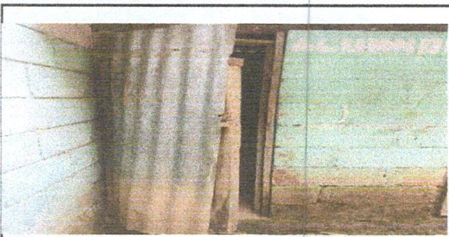
Foto 5: mejoramiento de paredes de servicio sanitario
