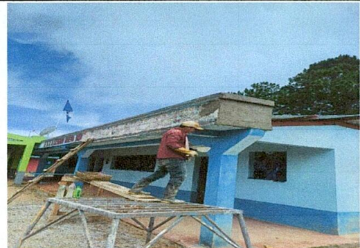
Foto 6: ALISADO DE MURO DE TECHO EN PROCESO
