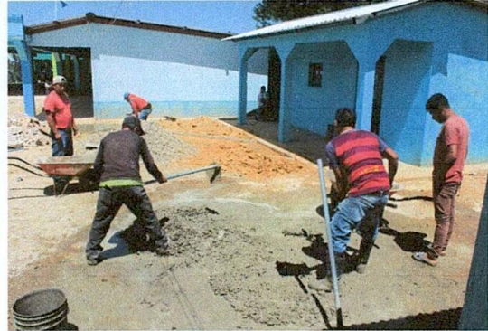
Foto 2: SUSTITUCION DEL PISO EN PROCESO
